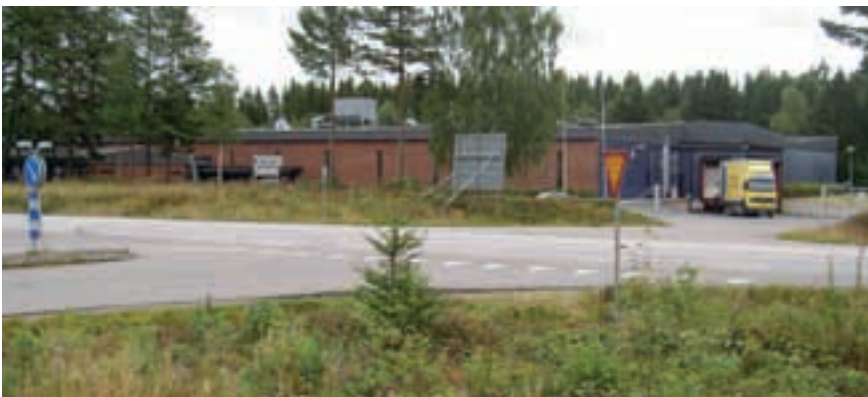
Från vecka 16 har Elitfönster AB haft verksamhet i JOC:s tidigare lokaler.
